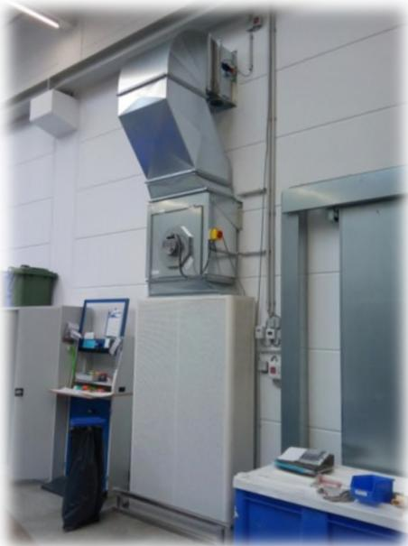
Für die Zuluft wurde ein Drucksensor montiert, um den Betriebspunkt kontrollieren zu können. Ein Plus an Instrumentierung erzeugt mehr Transparenz im Prozess und erlaubt eine Analyse des Betriebszustands. Der Quellluftauslass wie im Beispiel soll eine strömungsarme Luftverteilung ermöglichen.
