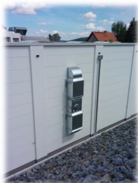
Der Abluftventilator hat zum Beispiel einen Kanalschalldämpfer, der bei der sich einstellenden Luftmenge einen externen Druck von 150Pa erzeugt. (Man trifft die geplante Luftmenge, wenn man den Differenzdruck an Bauteilen messen kann).
