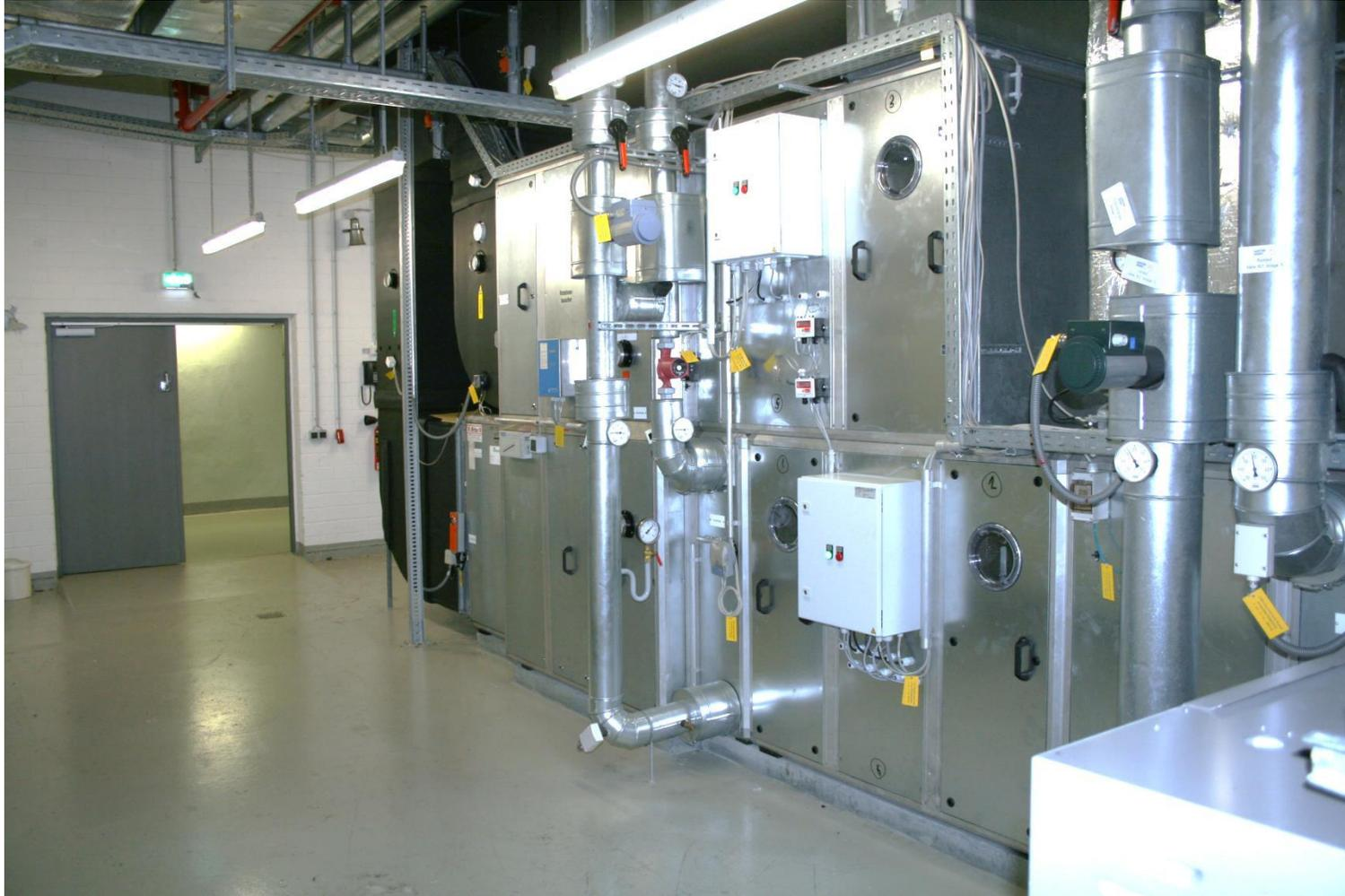
**Links.** ECFanGrid Retrofit Anlage nach dem Umbau mit angebrachten Schaltschränken.
