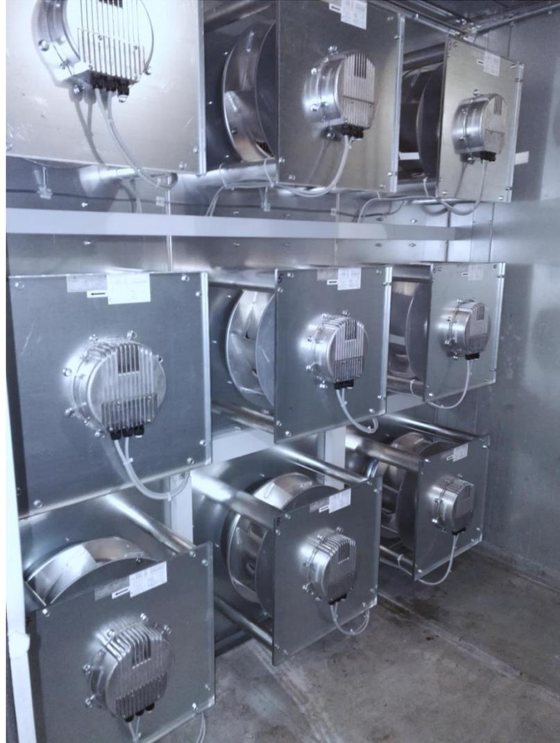
3x3 ECFanGrid mit zentraler Ansteuerung Schaltschrank und integrierter Volumenstromanzeige.
