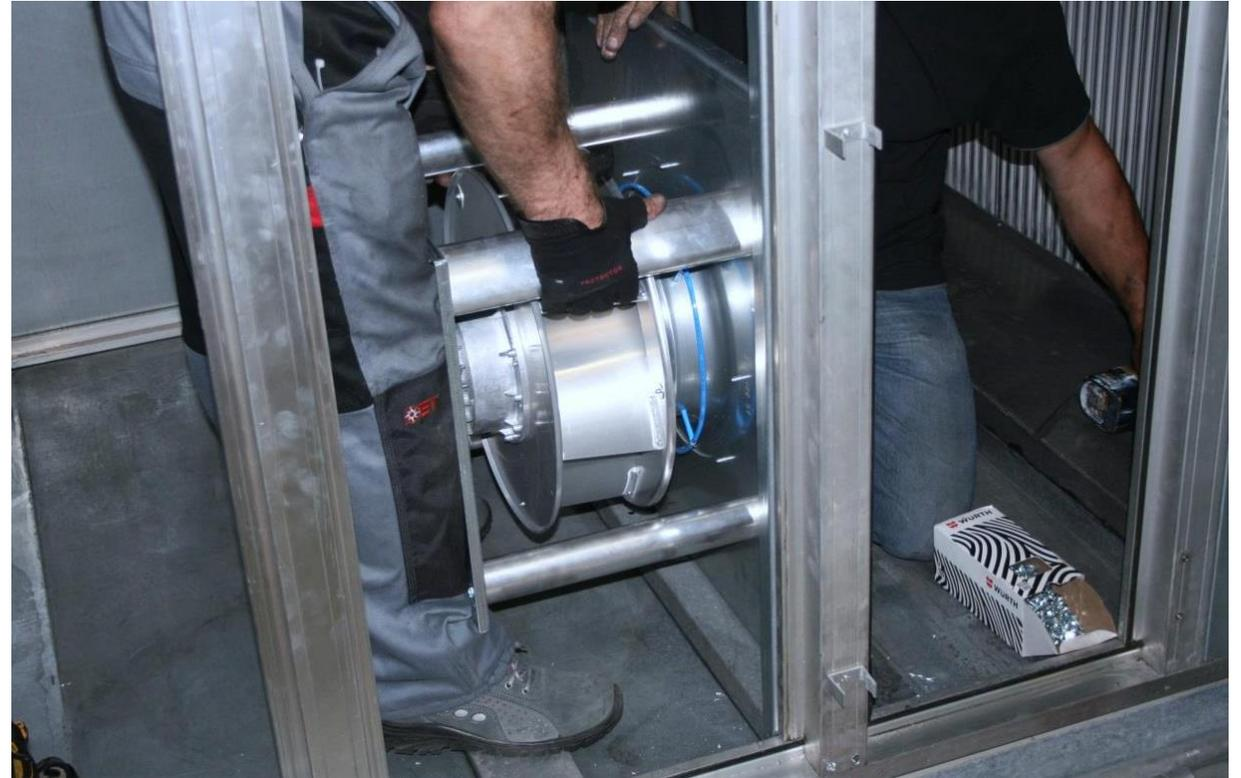
Die Installation einer EC Fan Grid kann von zwei Personen ausgeführt werden.
