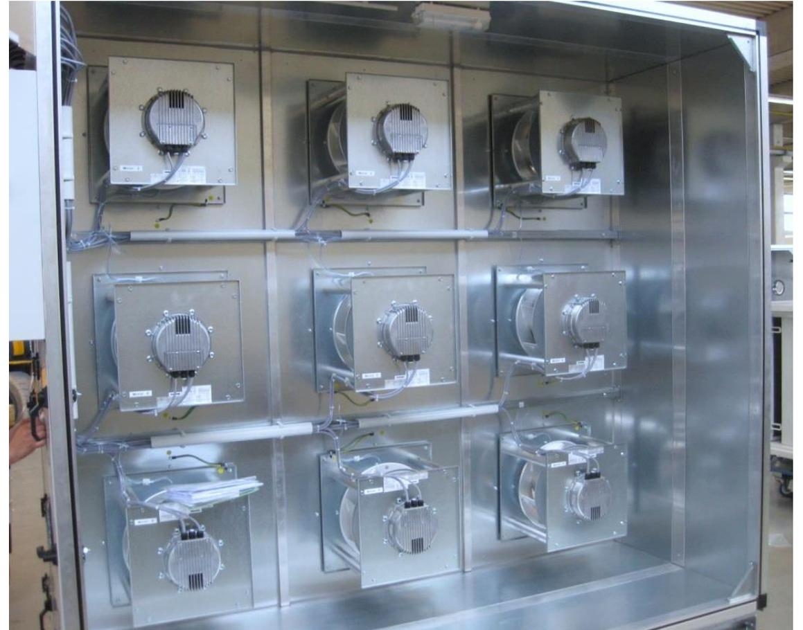
**Druckseitige Ansicht. Der Boden ist komplett frei zugänglich – einfache Reinigung.**
